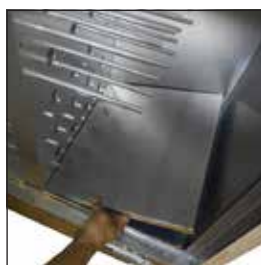
A3. Retirar los paneles de acabado en aluminio
